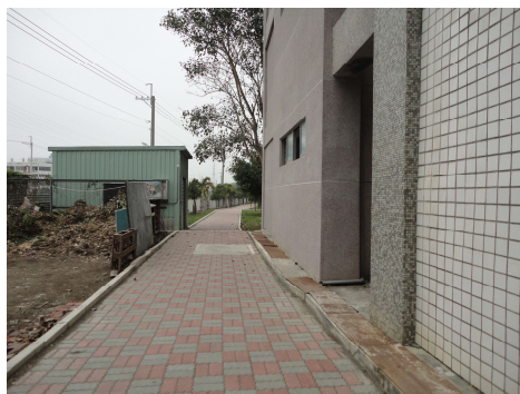
機械科一館西側邊坡
