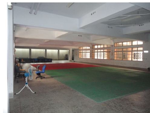
行政大樓地下室
