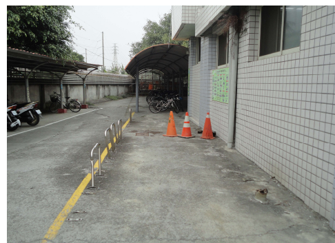
綜職科旁廁所週遭及機、腳踏車棚
